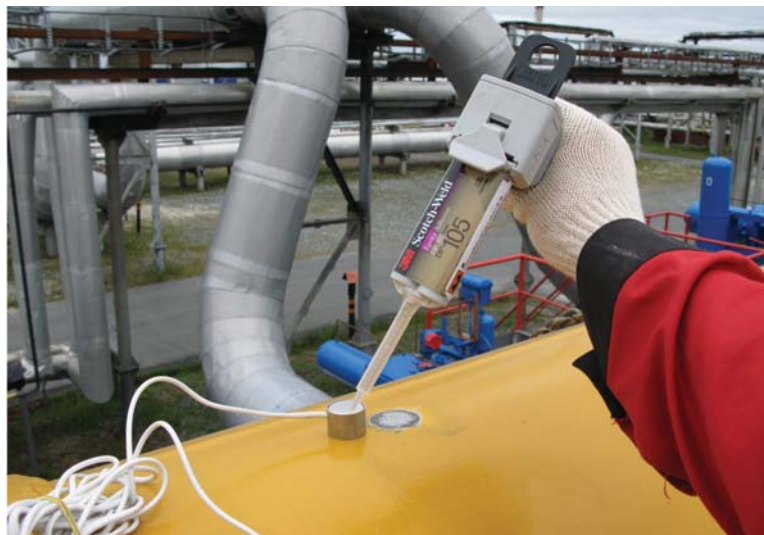
Монтаж магнитоанизотропного датчика на трубе
